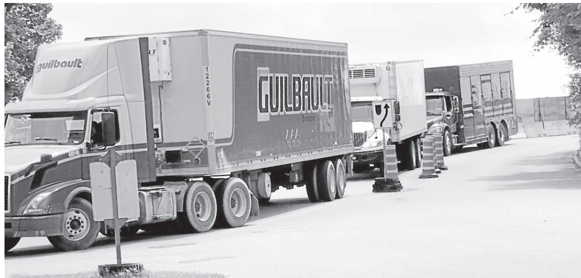
Plusieurs camionneurs ne respectent pas la signalisation et s'aventurent tout de même sur le viaduc Saint-Marc pendant les travaux de réfection. — PHOTO: COURTOISIE
