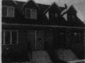
82 — BROSSARD: Construction neuve et rien à faire, ce 4 chambres avec foyer, salle à manger peut être à vous. G. MORIN. 676-7955.
