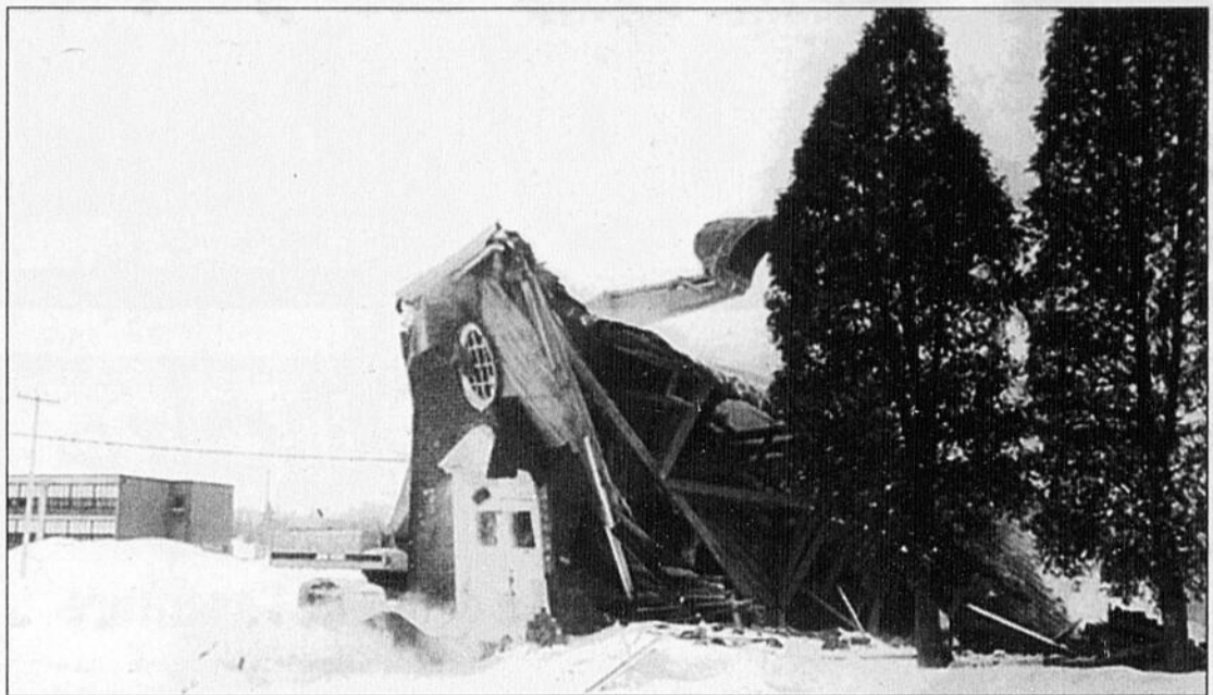
DOMMAGES - La démolition était envisagée depuis que des travaux de rénovation avaient révélé des dommages beaucoup plus importants que prévu causés à la structure en raison du déluge de juillet 1996.
