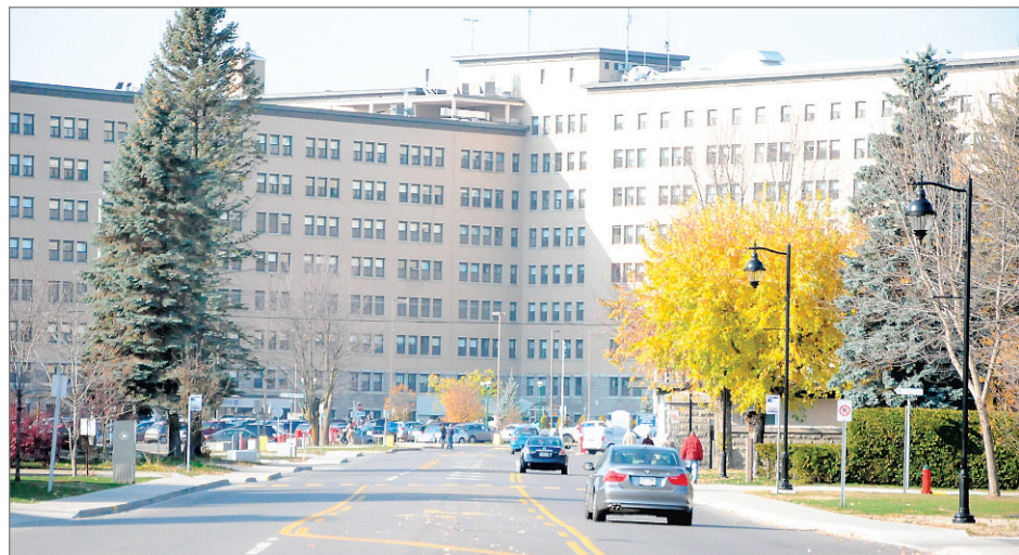
Les travaux de rénovations de l'unité 2-C ont été suspendus à cause de traces d'amiante retrouvées dans les murs. PHOTO ARCHIVES
