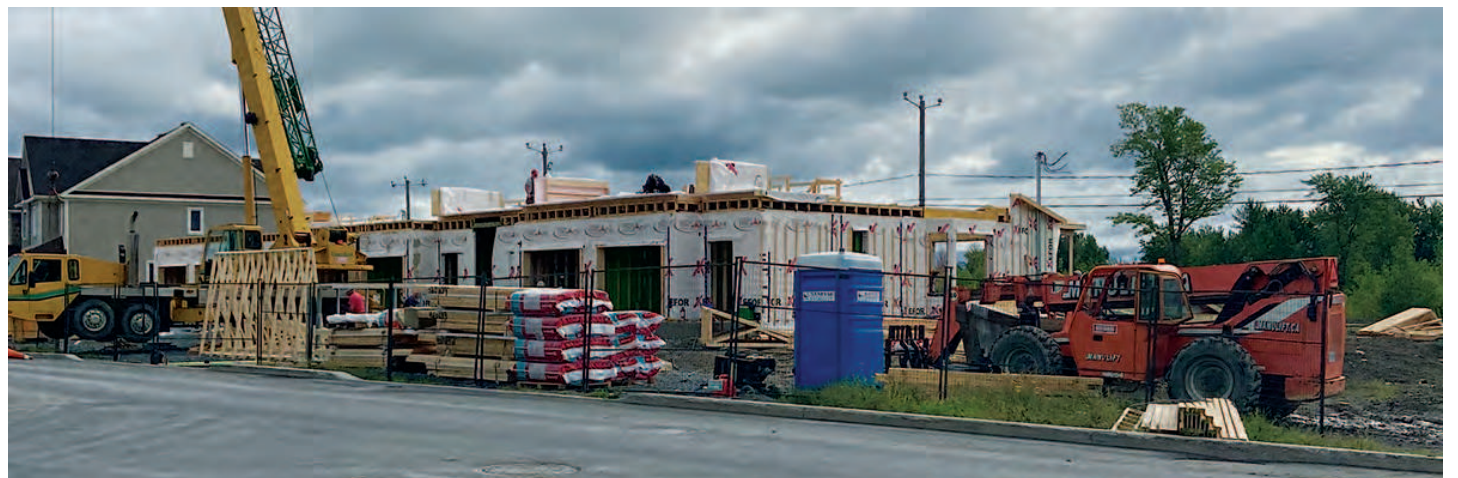
Les travaux du chantier sur la rue Daigneault sont suspendus. (Photo : Chloé-Anne Touma)
