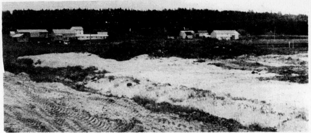
La partie de terrain qui semble plus pâle, au centre, est en fait une couche de bran de scie provenant du plus gros tas, près de l'usine MAP. Bientôt, on le recouvrira de terre.
