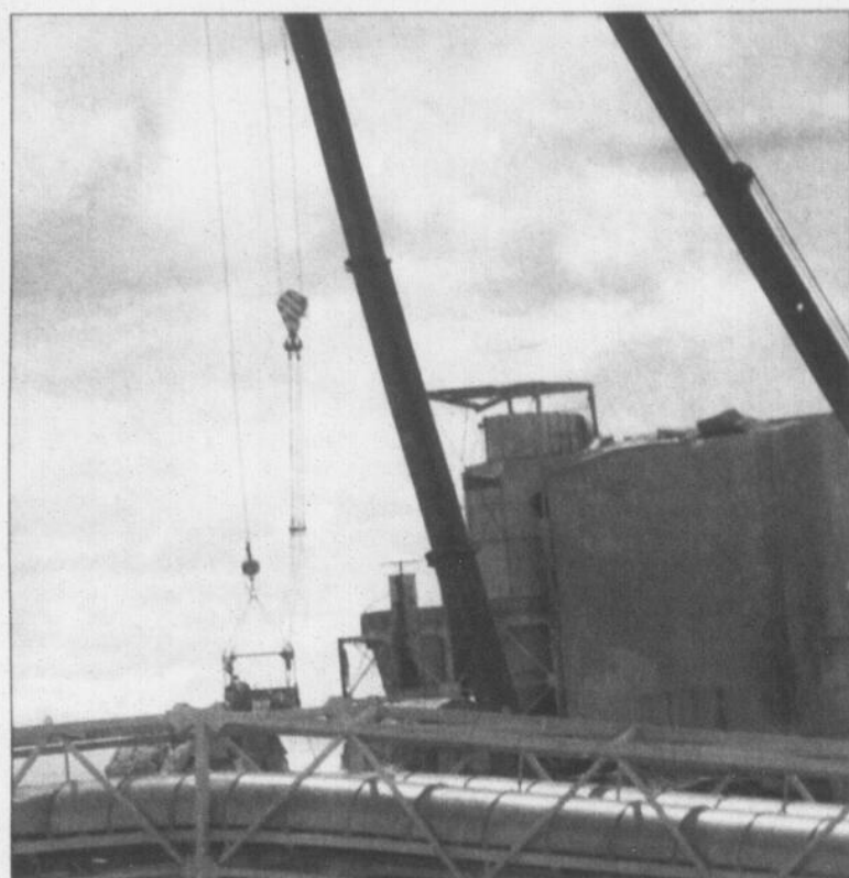
Huit grues géantes comme celles-ci s'affairent à démanteler les structures en pleine zone sinistrée.
