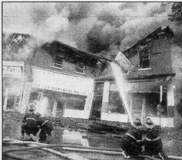
Le chemin de Montréal se transformera à la suite de nombreuses déflagrations.
