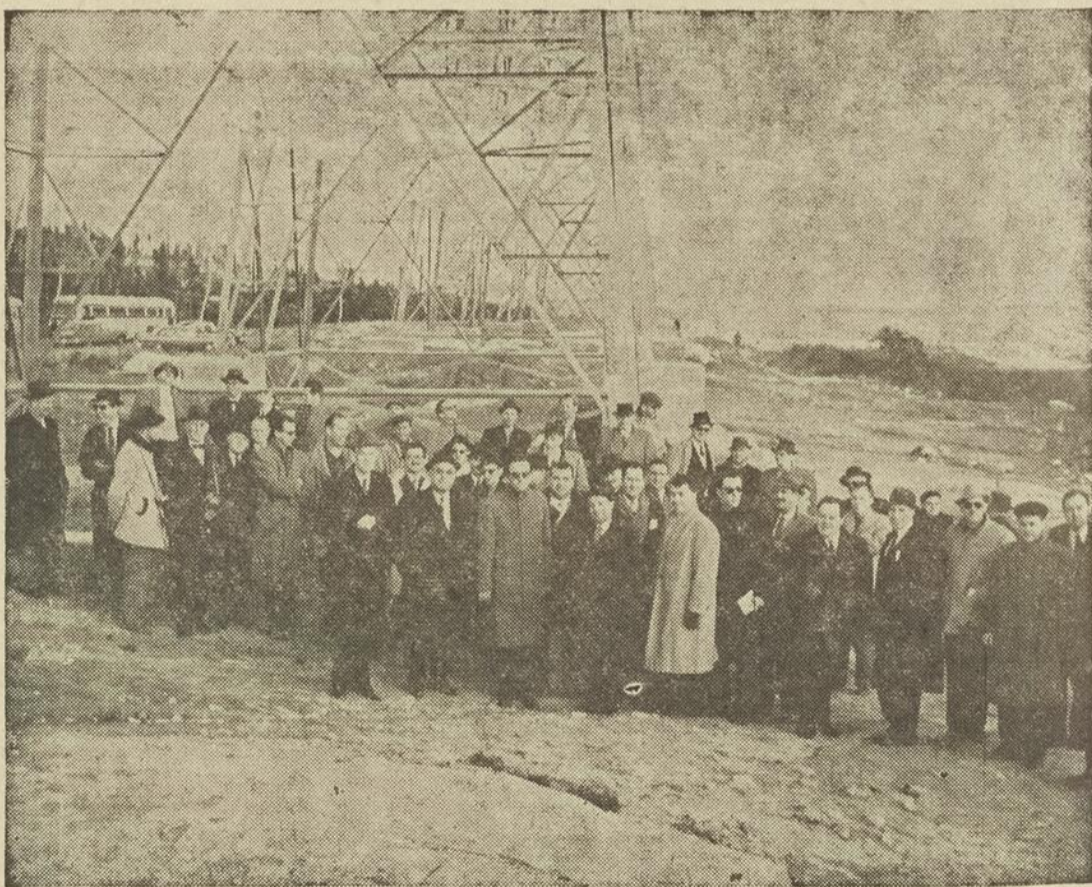
Les journalistes groupés pour le photographe au pied des structures de la traversée du Saguenay.
