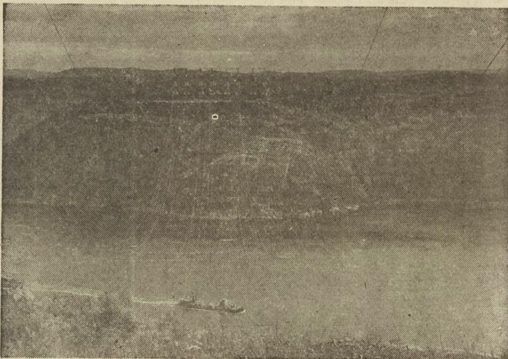
La ligne de ransport Bersimis-Québec-Montréal de 300,000 volts compte 1,717 pylônes d'acier. On voit ici la traversée du Saguenay.
