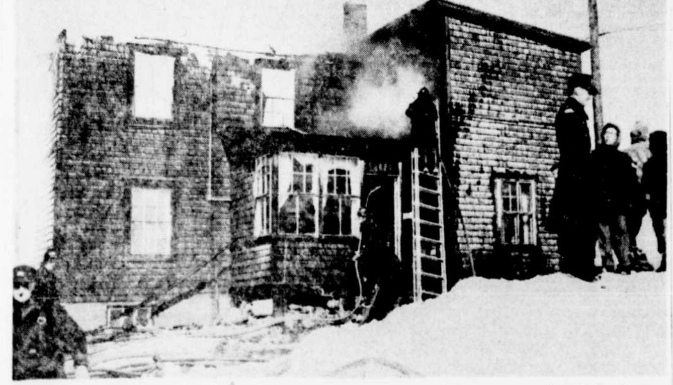
Desastreux incendie rue Fraser. — Un incendie poussé par un vent violent a ravagé une maison de bois à deux étages, hier midi, rue Fraser. Cinq voitures de pompiers ont dû se rendre sur les lieux pour combattre les flammes.
