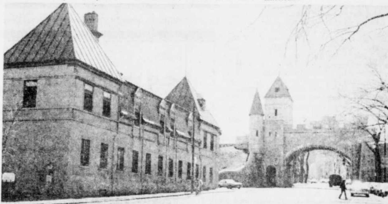
Le club de la Garnison a été construit en 1819 et on a ajouté un étage en 1982.
