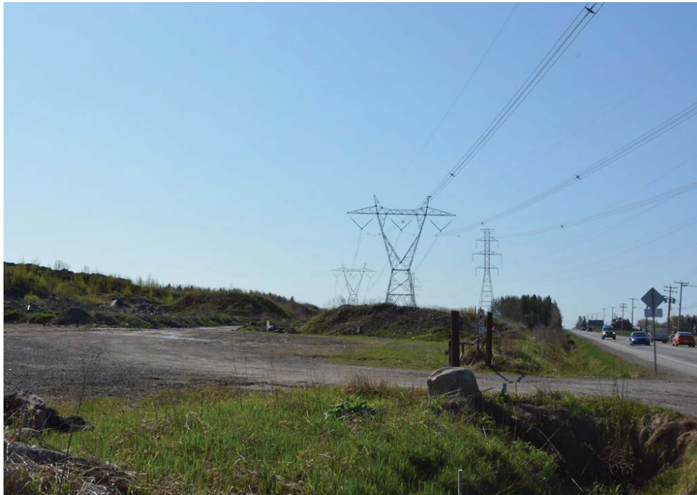
Terrain du côté est du boulevard de la Colline Photo : Mélanie Vincent
