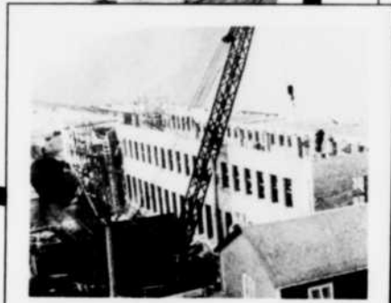
Construction du bureau principal en 1947.
