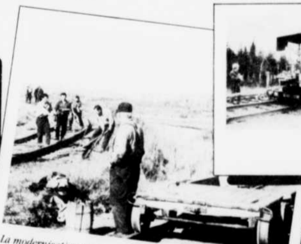
La modernisation des équipements a permis d'améliorer les conditions de travail des employés, notamment pour la pose des rails.
