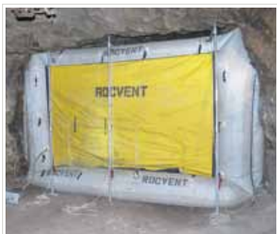
Barricade pneumatique installée
