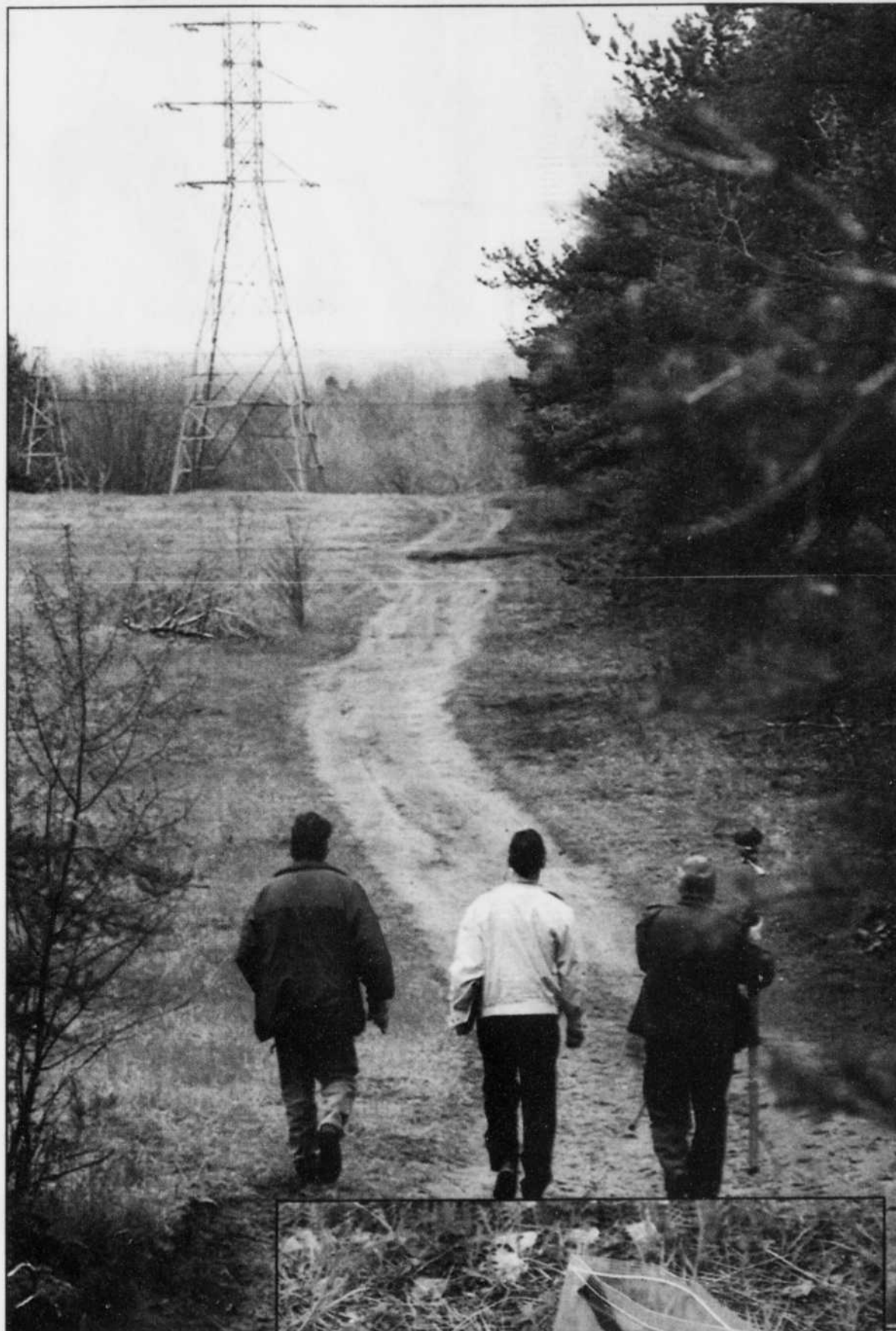
(Image-Média: Alain Bédard) Un employé du service d'exploitation et un enquêteur d'Hydro-Québec ont accompagné un policier pour constater la présence d'un engin suspect (ci-contre) placé au pied d'un pylône d'une ligne à haute tension, hier matin, à Sainte-Marthe-du-Cap.
