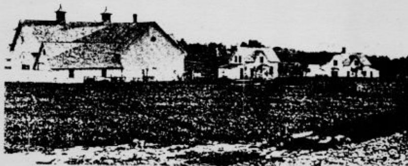
Ingelside, bâtiments de ferme et maisons des ouvriers agricoles
