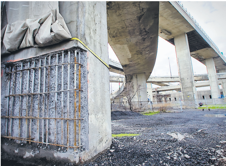
Une des structures de l'actuel échangeur Turcot.
