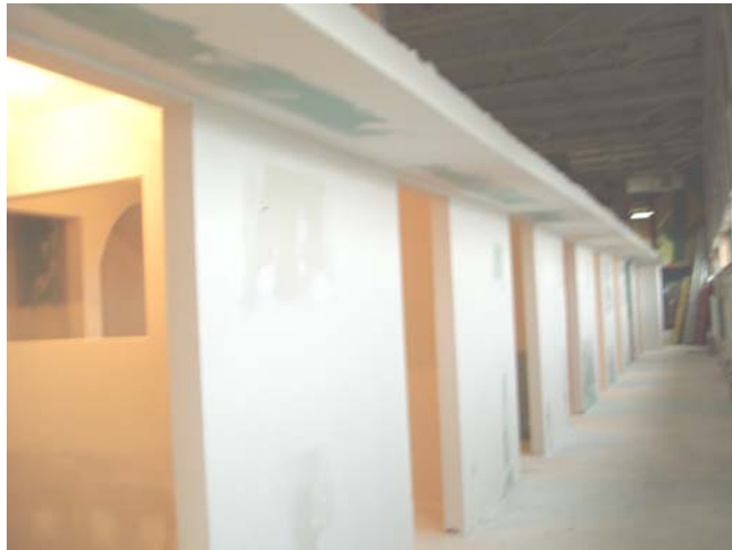
Figure 9 : Surfaces extérieures des enceintes de l'atelier de plâtrage
