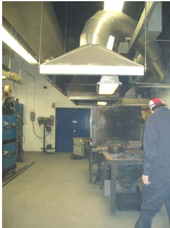
Figure 6 : Atelier de soudure
