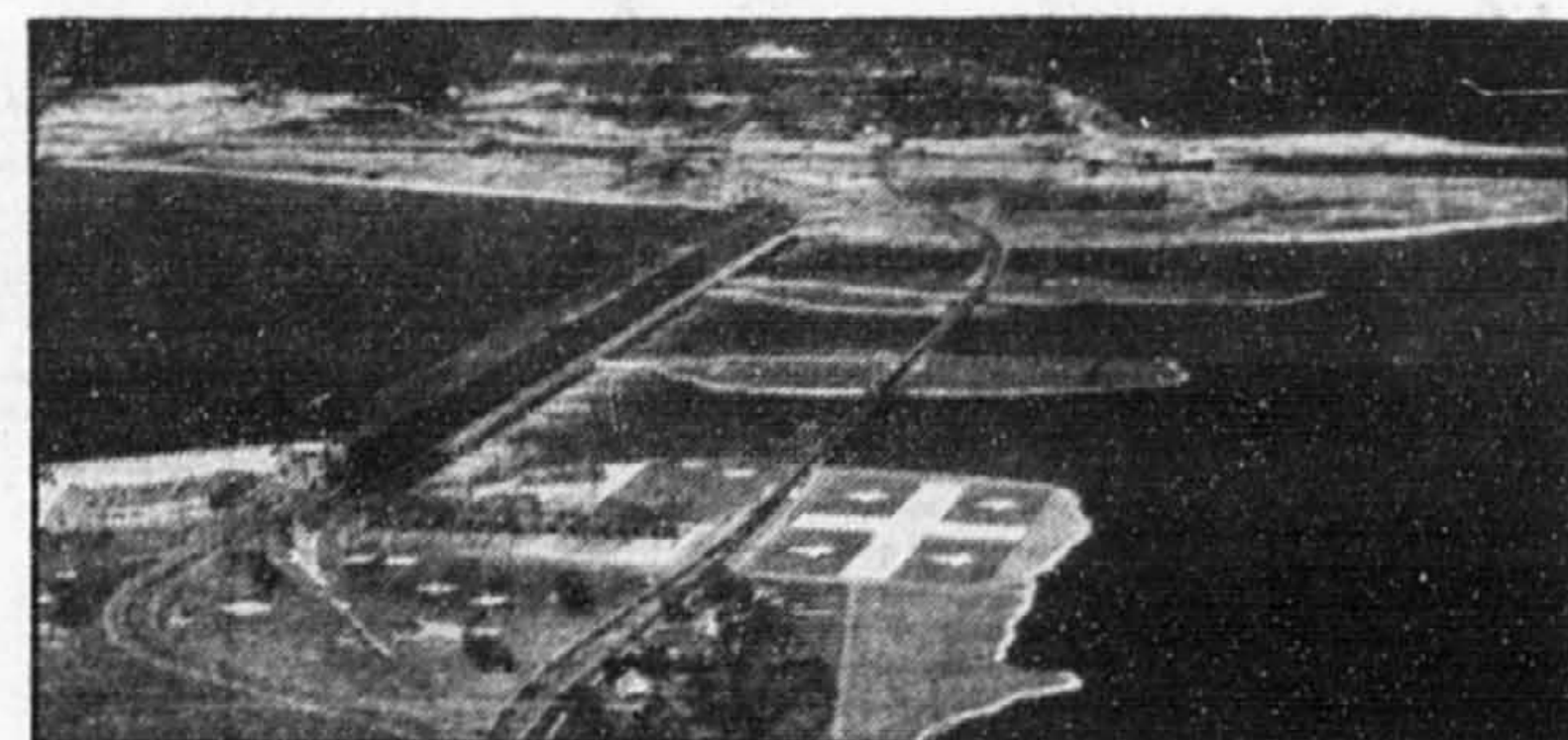
La centrale de Beauharnois.
