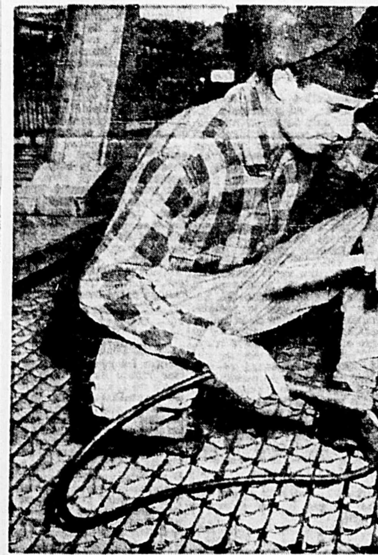
DEPUIS 25 ANS, le pont de Ste-Anne n'a pas changé sauf peut-être le tablier de la travée tournante. Le bois créosolé qui le pavait a été remplacé par un treillis métallique qu'un soudeur, M. Julien Collagaris, est en train de renforcer.
