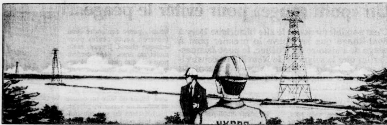
Du côté de Grondines, une vue des futurs pylônes.
