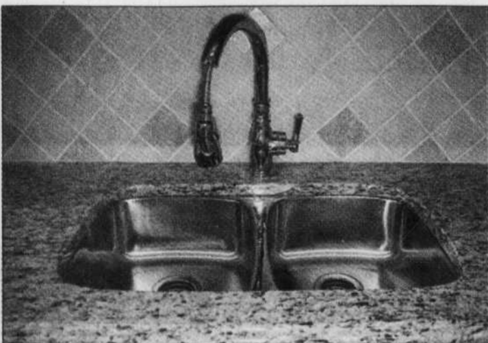
Robinet de style resto avec douchette intégrée installé ici sur un comptoir de quartz.
