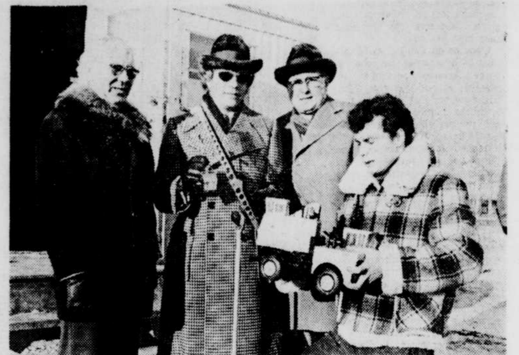
La première pelletée de terre levée, c'est un grand pas de fait vers la réalisation du campus du CEGEP de Shawinigan. L'événement a été marqué par une cérémonie à laquelle participaient des centaines de personnes, sur le site même du futur CEGEP. On voit ici MM. Léon Turgeon, directeur du bureau régional du ministère de l'Éducation, Jean-Guy Farrier, directeur général du CEGEP, Pierre-A. Larocque, président du conseil d'administration et Étienne Marchand, président de l'Association des étudiants, tenant dans ses mains le tracteur symbolique. (Photo Normand Rheault)
