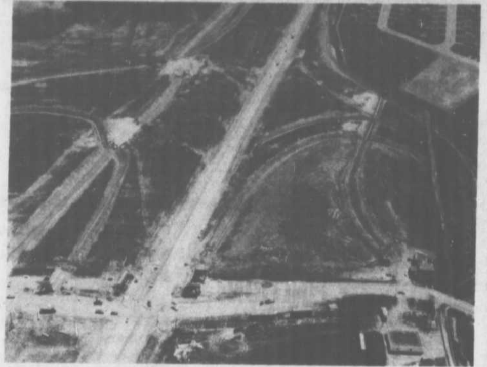
Les travaux du viaduc de la route 25 à la hauteur du boulevard Sainte-Marie. En bas à droite, on voit une partie du parc industriel de Mascouche. (Photo: LA REVUE)
