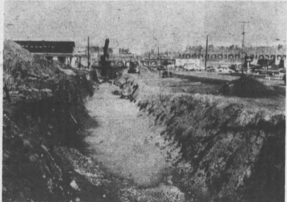
Les grands travaux de la route 337 à la hauteur de Terrebonne se poursuivent sans causer trop d'inconvénients aux automobilistes. Présentement, les travaux consistent à enfouir une immense conduite d'eau pluvial qui drainera les terres situées sur le côté ouest à Saint-Louis-de-Terrebonne, partie de Lachenaie, Mascouche-Heights et Mascouche-Ouest. (Photo: LA REVUE)
