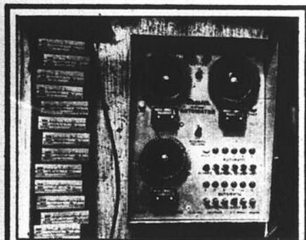
Dans une serre, tableau de contrôle de la minuterie qui arrose automatiquement les plantes.
