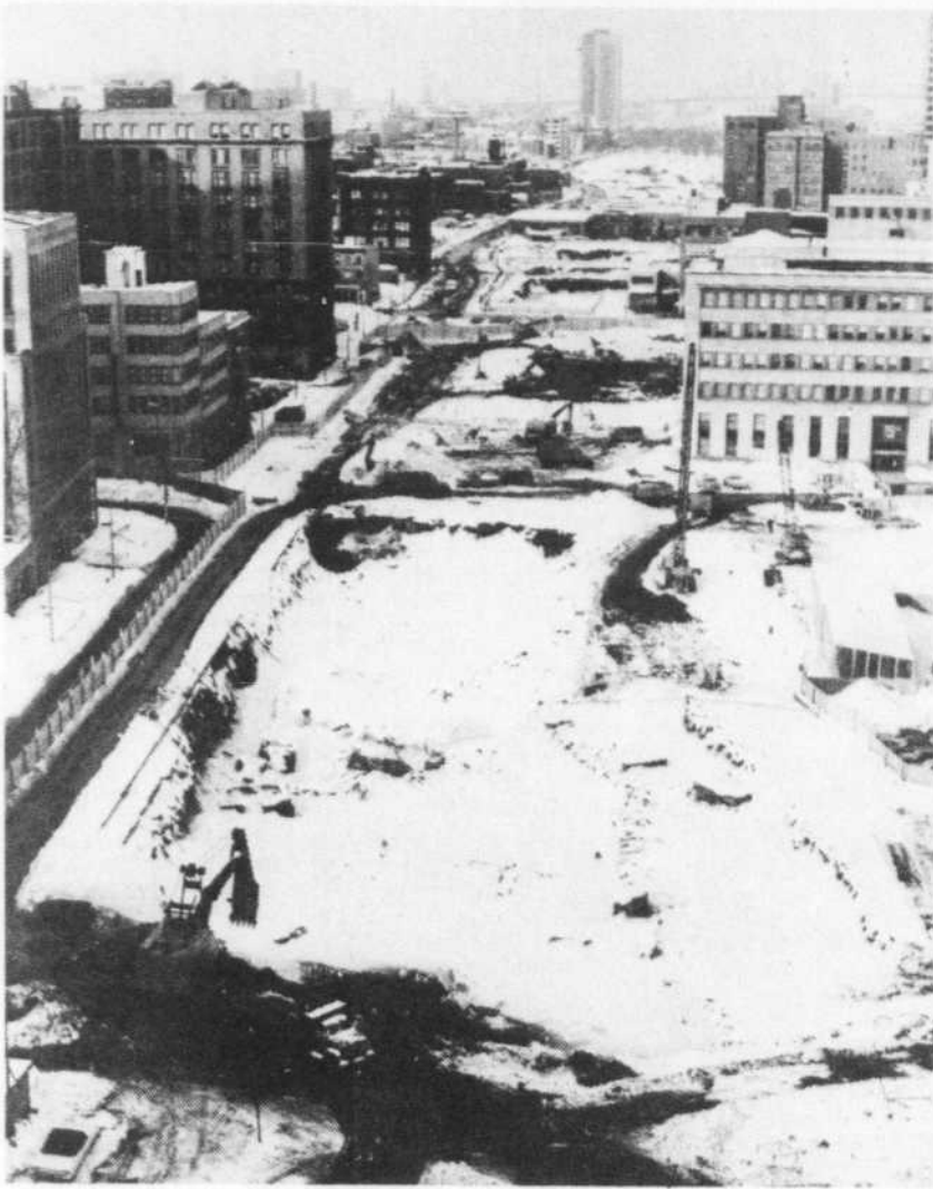
Pendant que le Front commun contre la construction de l'autoroute est-ouest multiplie ses démarches pour faire arrêter les travaux, ceux-ci vont bon train dans la partie ouest du projet, comme en fait foi la photo ci-dessus, prise de la Place Bonaventure en direction de l'est. (Photo Le Devoir par Claude Léger)
