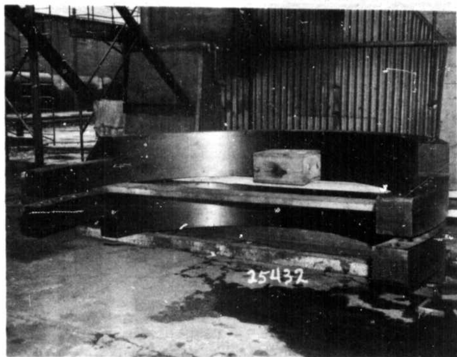
LE NOUVEAU PNEU attend qu'on vienne le chercher. On distingue très bien les deux sections qui devront s'imbriquer, une fois retournées.
