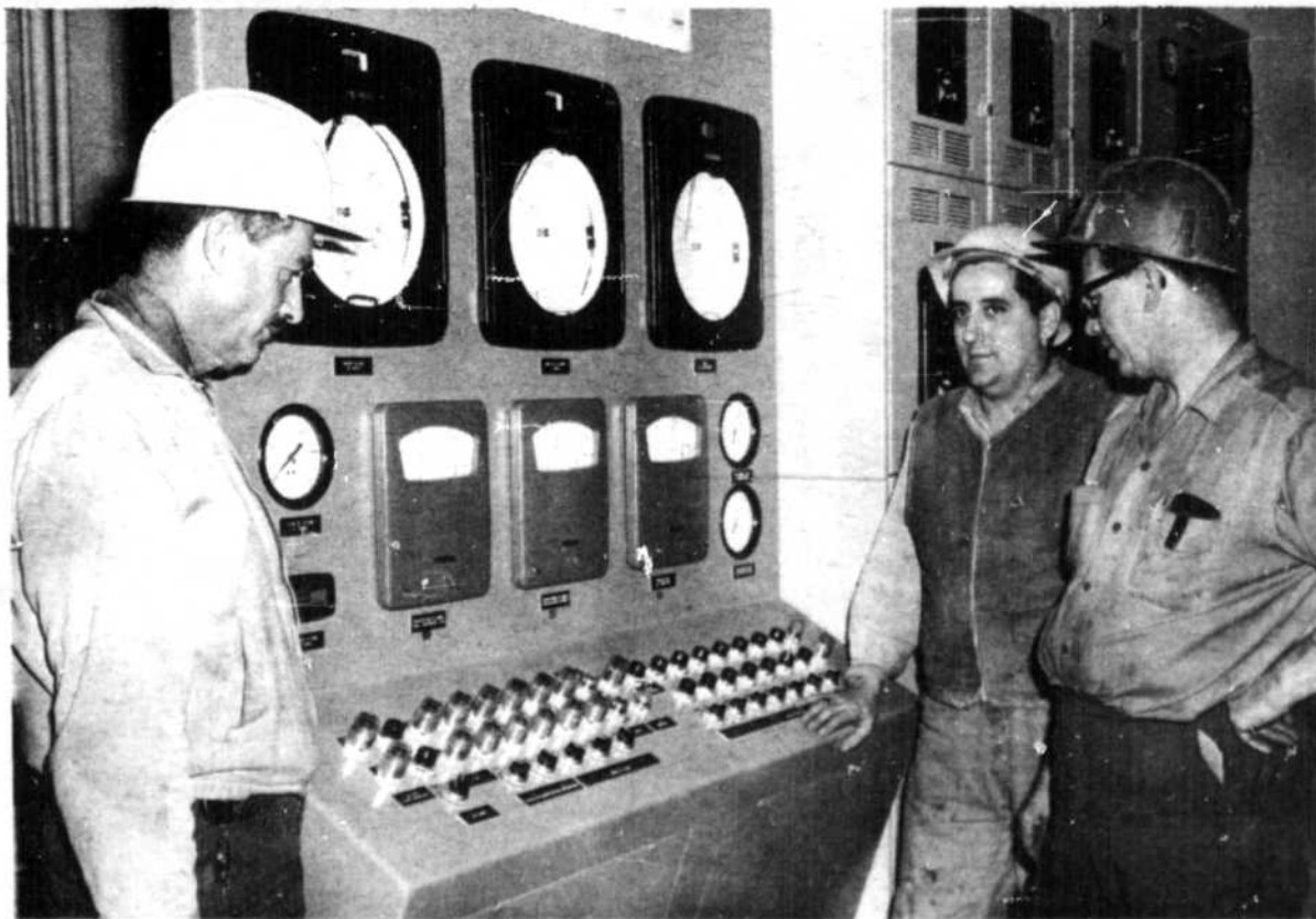
PRES DU TABLEAU de contrôle de l'usine de pompage, les employés ont repris leur poste. Dans l'ordre habituel, MM. Patrice
