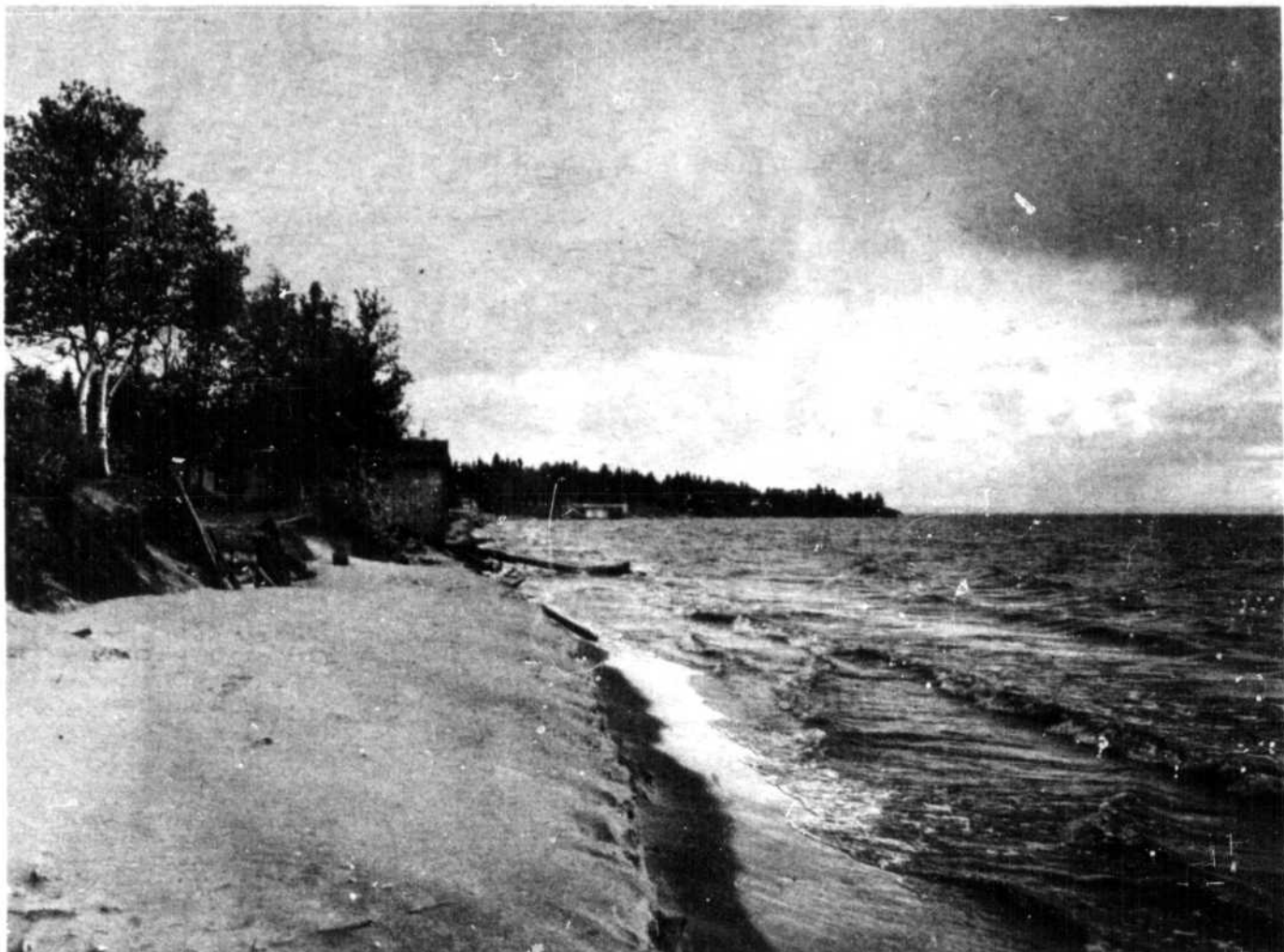
CES RIVES reconstituées l'an dernier par Forces Motrices du Saguenay subissent maintenant l'effet des forces de la nature. Depuis quelques jours les travaux ont été repris et se poursuivent.
