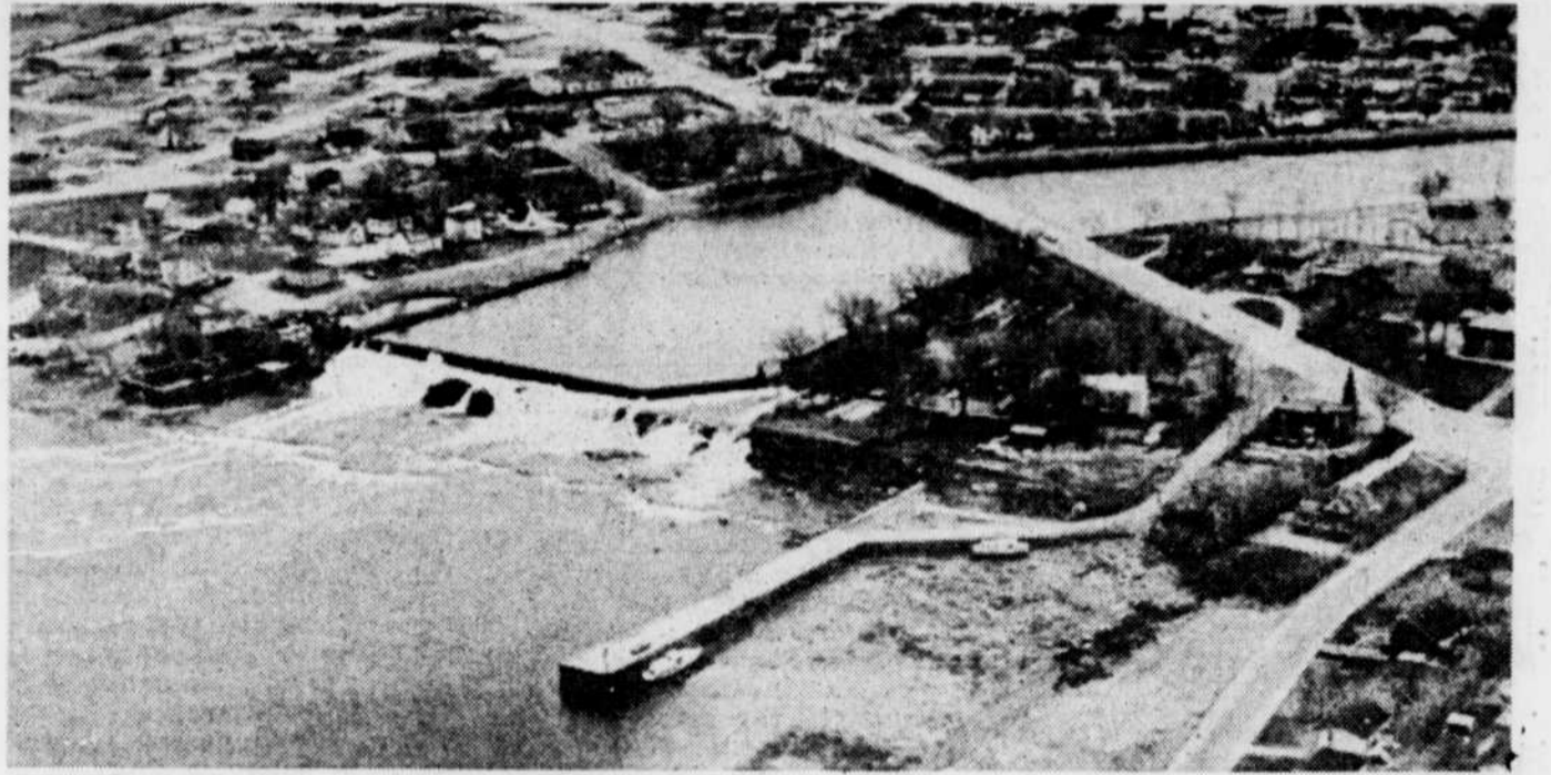
Quand la marée est basse, le quai de Montmagny est à sec.
