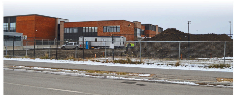
Les travaux de construction de l'école secondaire Pierre-Bédard ont commencé le 2 décembre. Photo: Coup d'oeil - Marc-André Couillard
