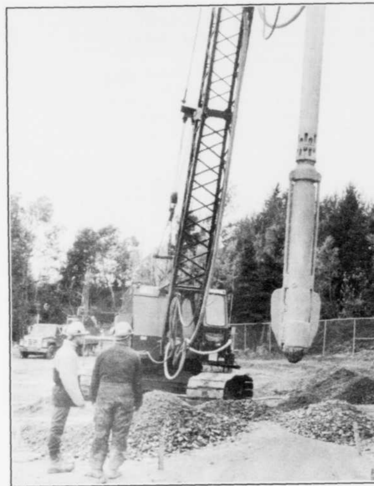
La tige en métal à bec gicleur entre profondément dans la terre. Le trou est ensuite rempli de pierre concassée pendant que la tige métallique remonte lentement, en vibrant, pour favoriser le compactage du sol.
