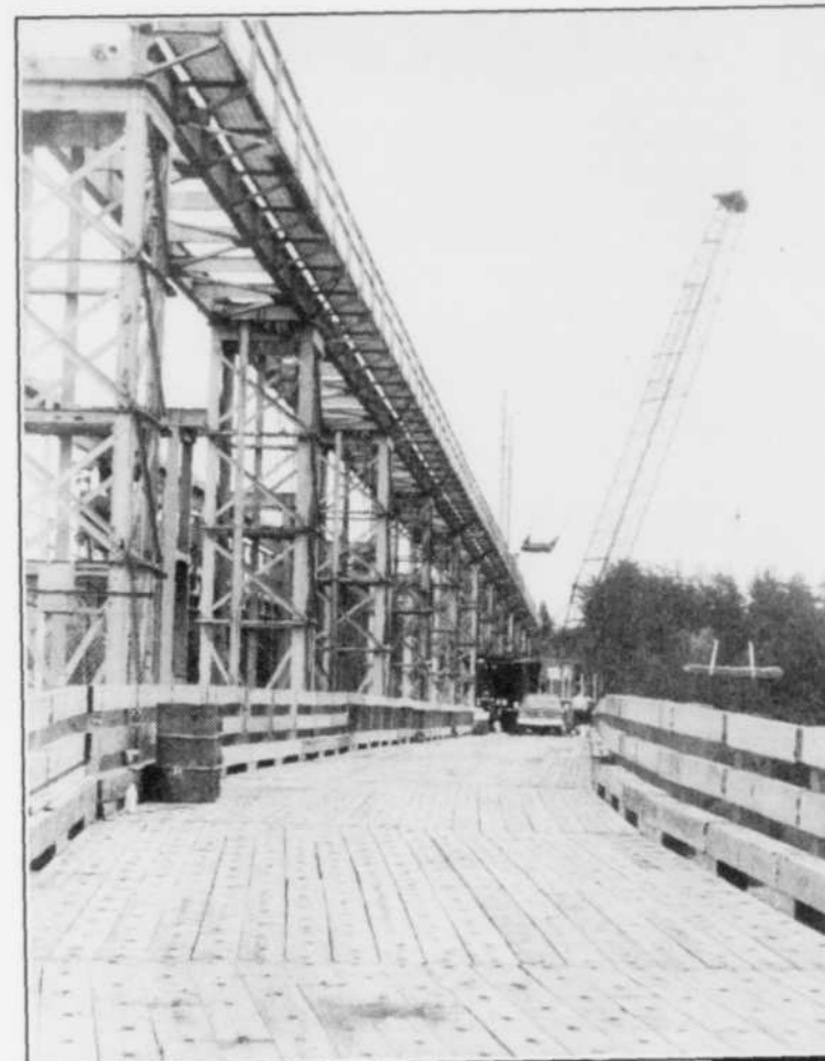
Voici une vue du pont en construction sur l'évacuateur numéro 4. Reposant sur une structure d'acier, le revêtement de bois s'harmonise avec l'environnement.
