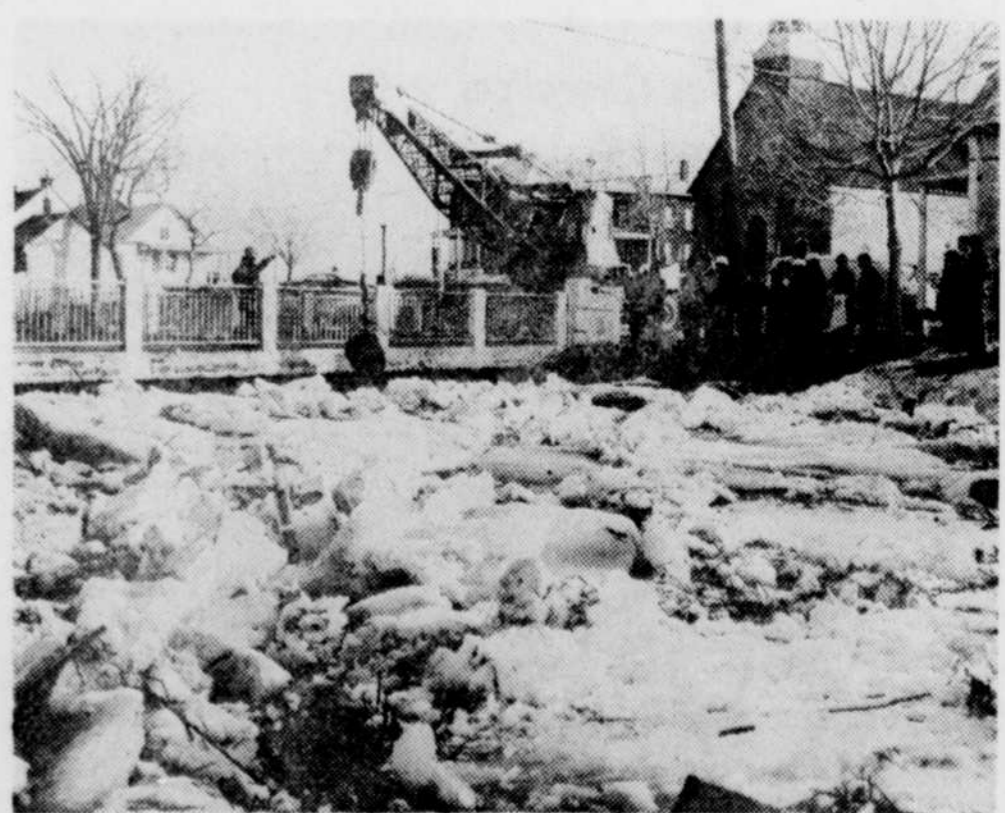
La crue des eaux printanières a commencé à faire des siennes dans la région de Joliette. En fin de semaine, le pont Brassard, au coeur de la municipalité de Saint-Paul-de-Joliette, était menacé par l'amoncellement de glace. Il aura fallu
