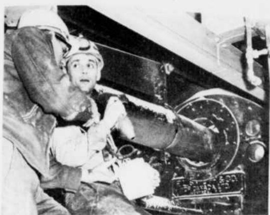
LA CALCINATION — Pour calciner les alumines spéciales devant servir pour des produits de céramique, de matières réfractaires et autres, l'alumine est chauffée dans des fours rotatifs. Durant le procédé les opérateurs doivent s'assurer de la température et pour ce faire ils ont des appareils de précision, tel ce pyromètre portatif que M. Jean-Guy Gauthier, aide au four rotatif, tient dans ses mains. Le contremaître Robert Tremblay l'accompagne.
