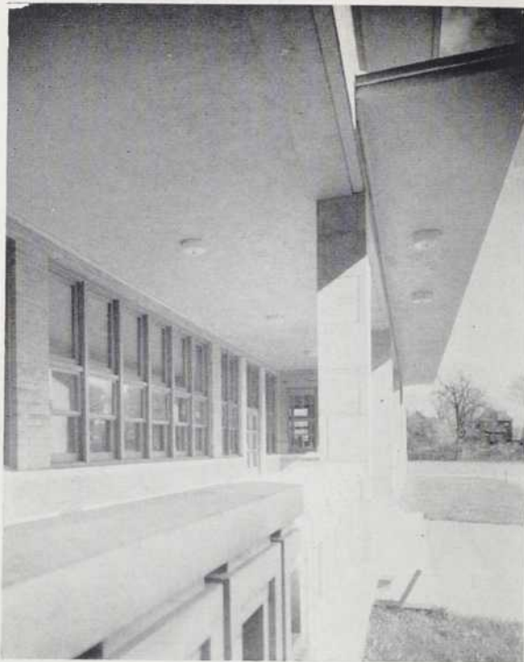
Détails de la véranda et de la marquise de l'entrée principale.
