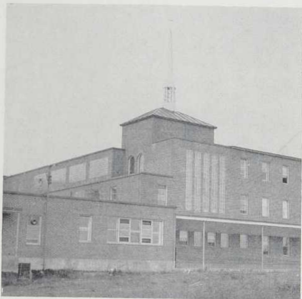
Vue de l'arrière du couvent montrant la flèche et le clocher. Au premier plan, à gauche, une partie du bâtiment des services.
