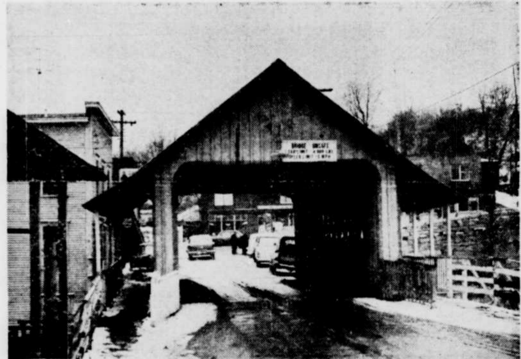
Avec trottoirs — Il s'agit bien de trottoirs et non de passages spéciaux à l'intention des petites voitures européennes.
