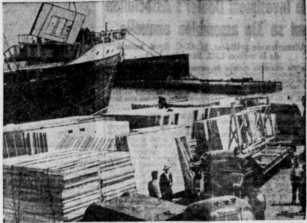
POUR TERRE-NEUVE — Cent maisons sont actuellement pré-fabriquées à Québec. On les expédiera à Terre-Neuve, pour alléger un peu la crise du logement là-bas. Cette photo montre les 30 premières de ces maisons, à bord d'un navire en partance pour Terre-Neuve.
