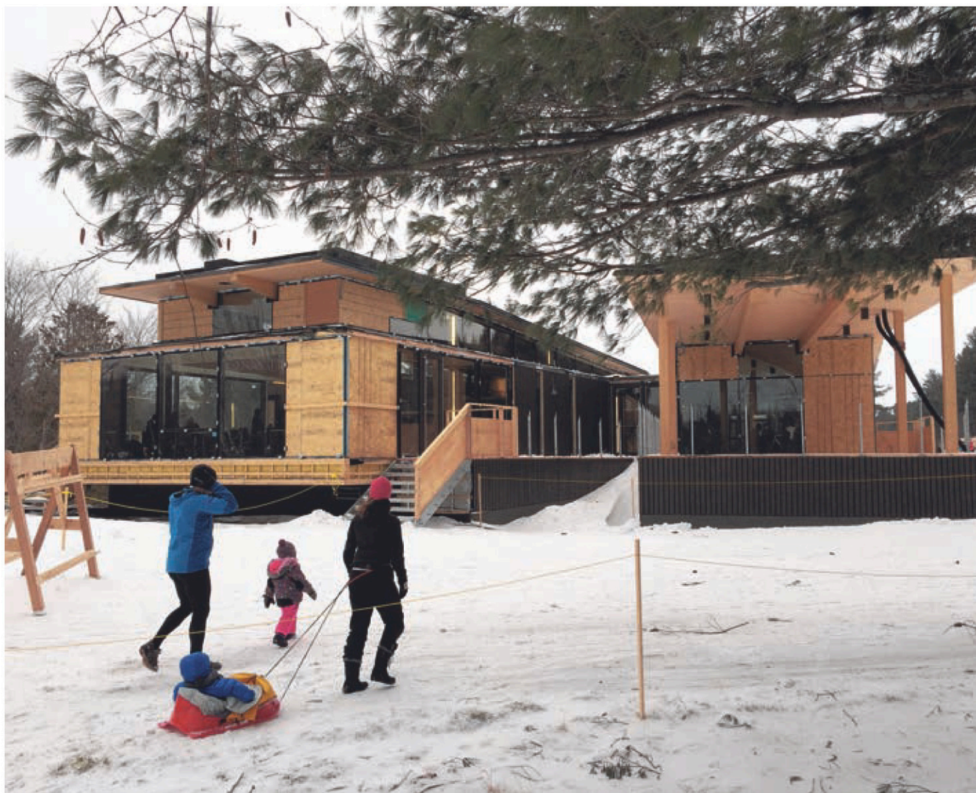
Le centre de services Le Cerisier, qui offre une superbe vue sur l'étang aux Cerises, est presque complété. Les travaux pour peaufiner les derniers détails seront effectués en avril. (Photo Le Reflet du Lac - Dany Jacques)
