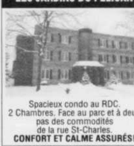
Spacieux condo au RDC. 2 Chambres. Face au parc et à deux pas des commodités de la rue St-Charles. CONFORT ET CALME ASSURÉS!
