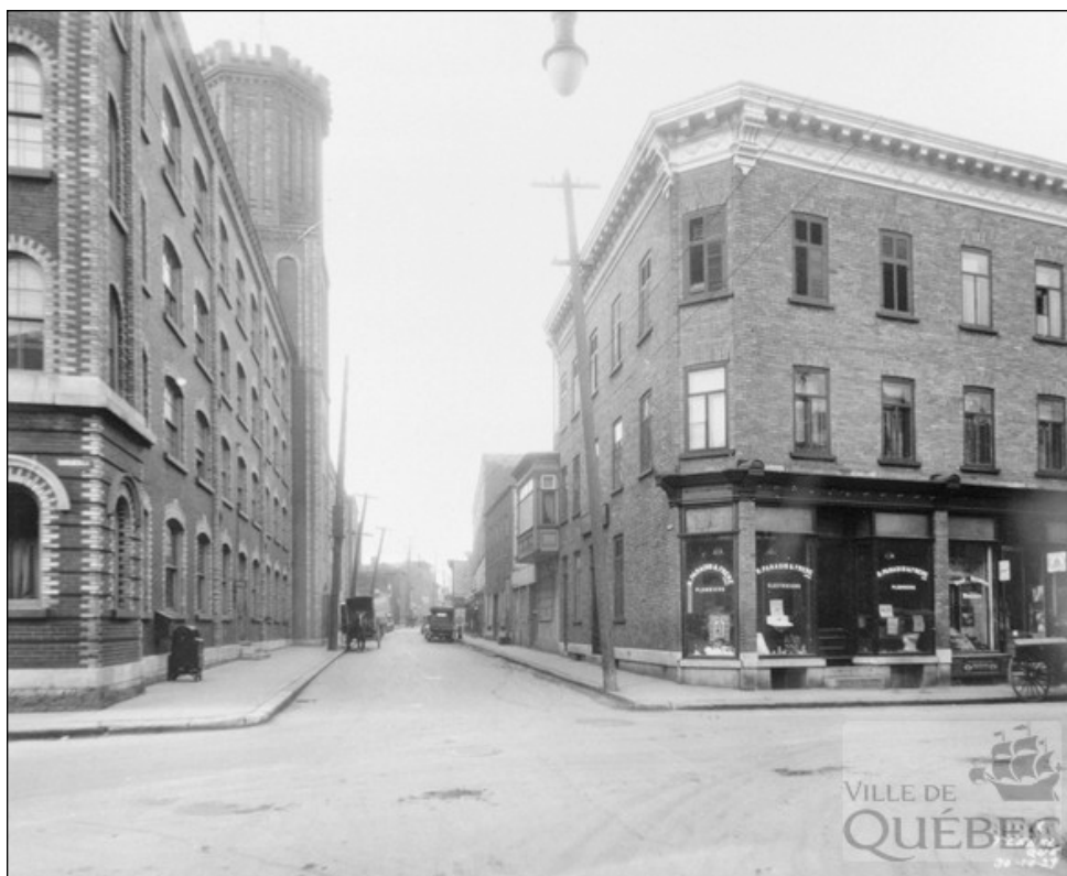
Image B : Vue vers l'ouest de la rue des Fossés (maintenant le boul. Charest) à l'angle de la rue Dorchester; on reconnaît la Dominion Corset. (B)
