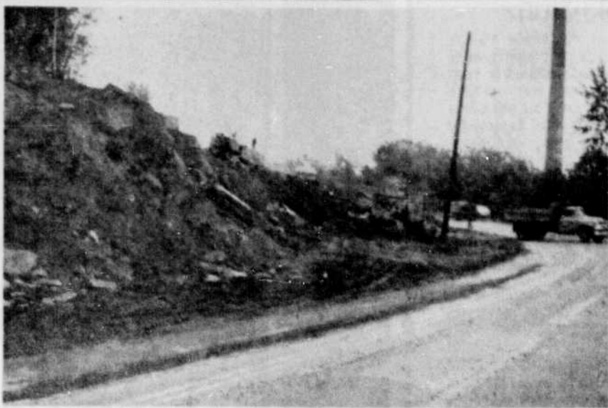
Le déblai disparaît — Les travaux vont bon train dans la courbe du moulin à Windsor. Deux bédiers mécaniques travaillent à arracher la terre au flanc de la colline et deux camions transportent cette terre à vive allure. On aura été chanceux de ne pas trop rencontrer d'énormes pierres ou de roc solide. Le poteau situé entre le chantier et la route doit disparaître sous peu.
