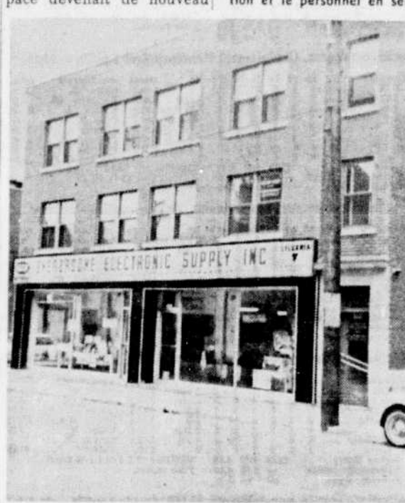
L'édifice dans lequel est logé le nouvel établissement de Sherbrooke Electronic Supply Inc.
