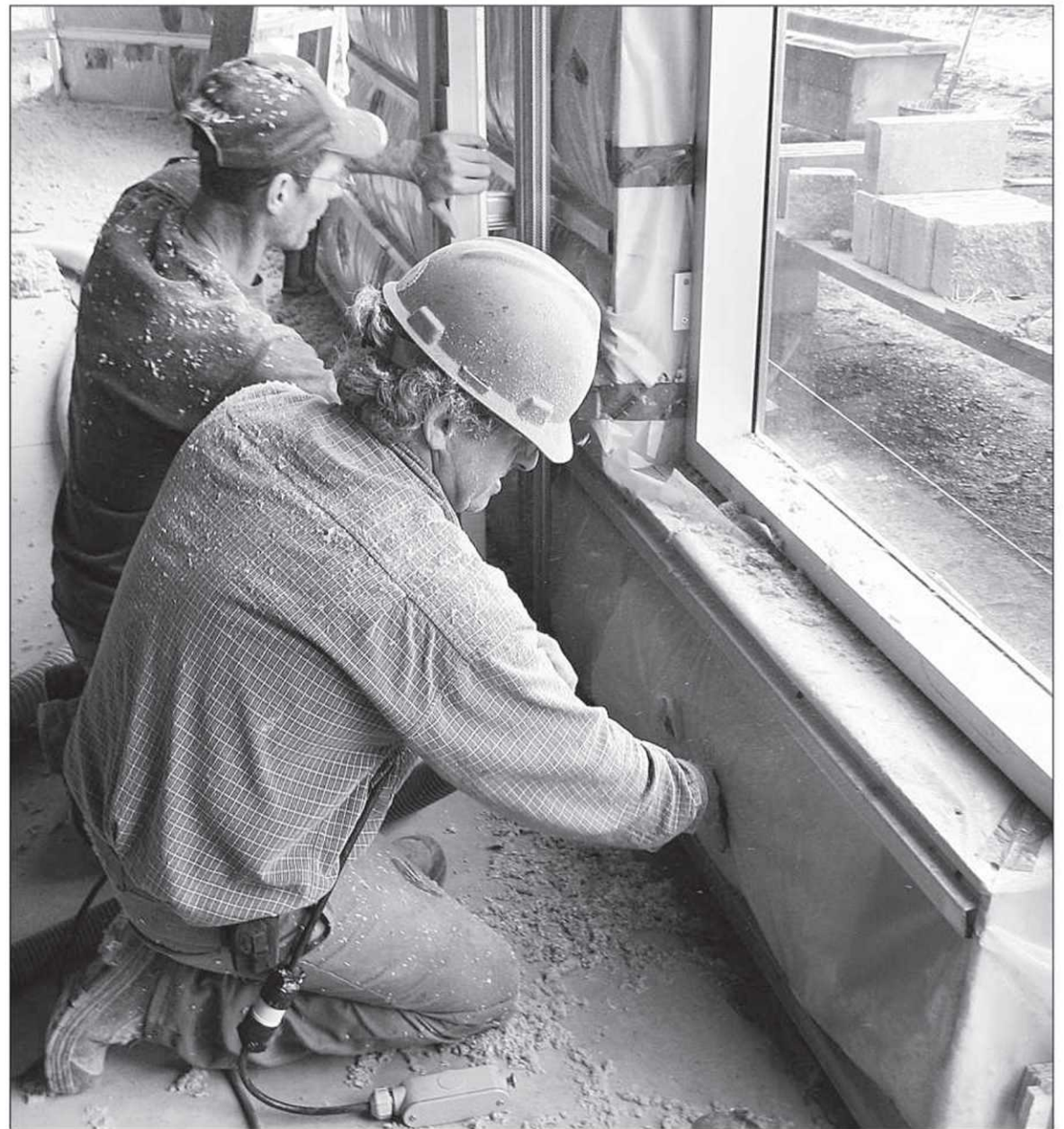
Outre la cellulose, constituée à 85 % de journaux recyclés et déchiquetés, les experts suggèrent la pose d'un panneau absorbant de son. On peut aussi ajouter des vitres. — PHOTOS ISOLATION IGLOO CELLULOSE
