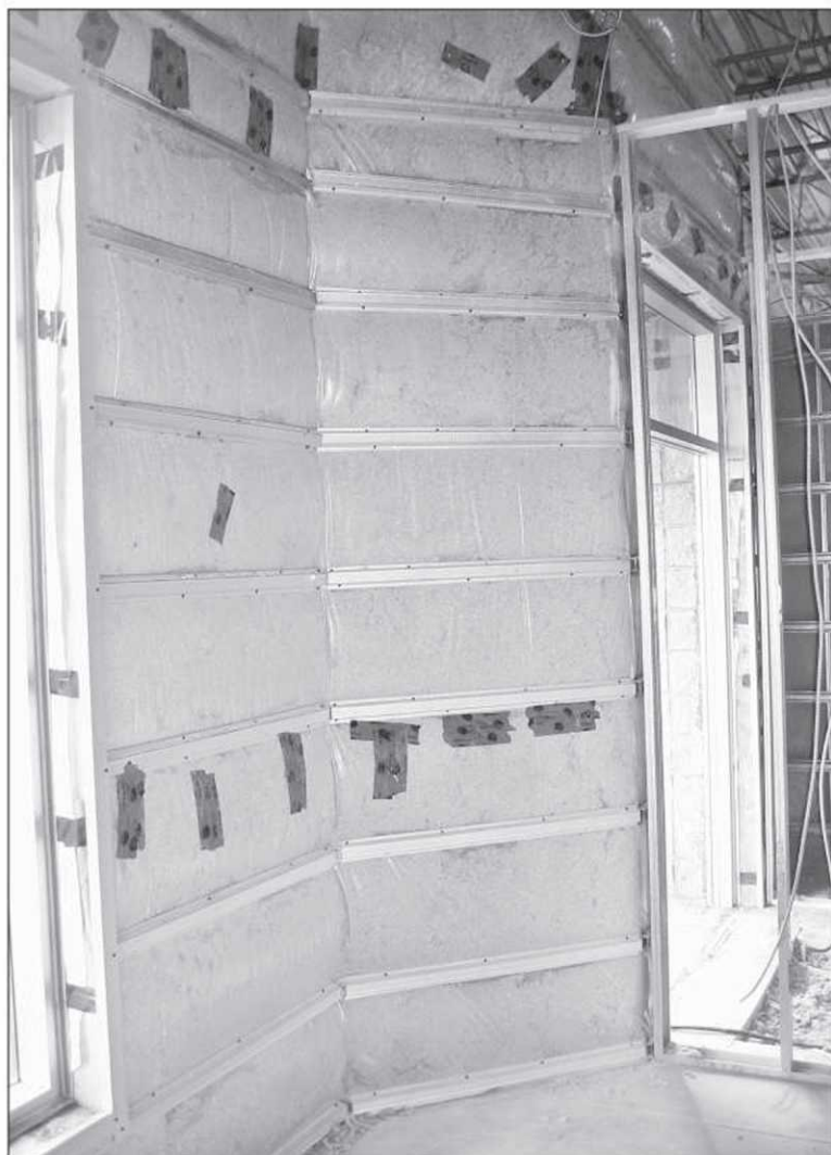
Les travaux d'insonorisation sont habituellement faits lors de l'érection du bâtiment.
