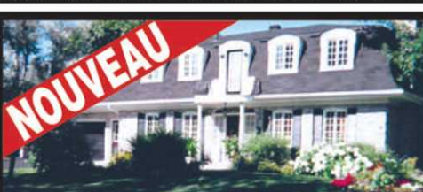
SILLERY , 1240, ERNEST-LAVIGNE, luxueuse et raffinée, rénovée depuis 1995, 5 cc, 3 sb, 2 foyers, piscine creusée. 895 000$
