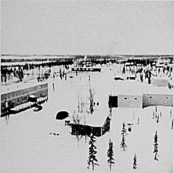
La rue principale d'Inuvik! Les édifices reposent sur des piliers pour empêcher la chaleur dégagée par la bâtisse de faire fondre le pergélisol, ce qui entraînerait l'écroulement des bâtiments. Il y a à peine cinq ans, cet endroit n'était qu'un désert de neige. Aujourd'hui, Inuvik vit pour demain.
