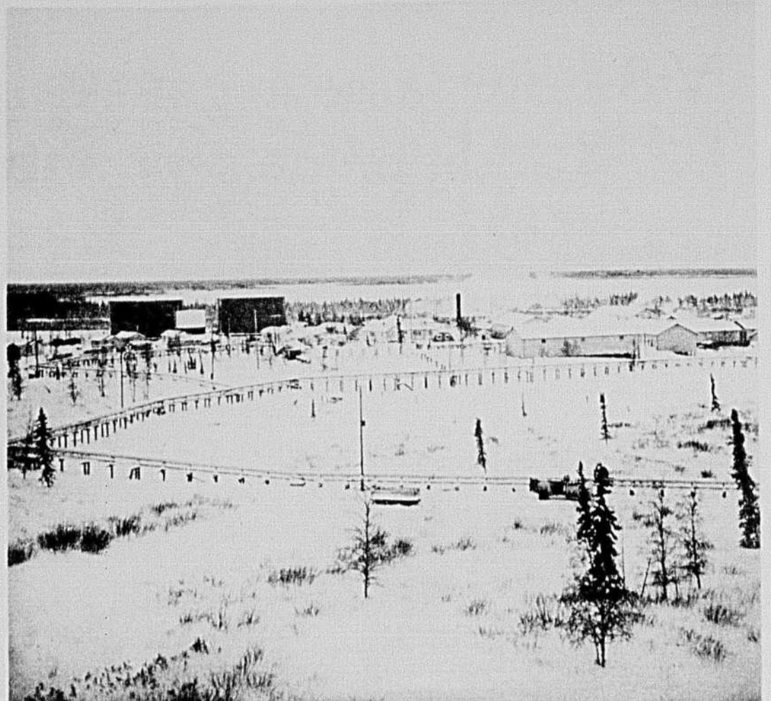
Toutes les bâtisses d'Inuvik sont reliées entre elles par d'énormes conduits isolés qui contiennent entre autres les tuyaux d'égouts et d'aqueduc ainsi que les tuyaux d'amenée de l'eau chaude destinée au chauffage.
