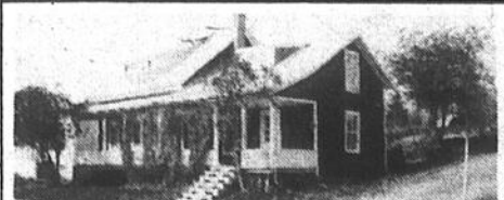
D:4087 - Résidence, rue Principale, St-Côme, Beauce; 43 x 22.5; 1 1/2 étage; 4 chambres; remise; terrain 60 x 70.
