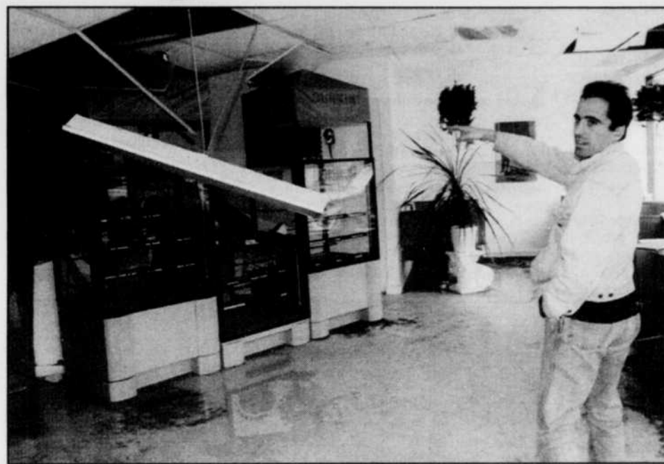
Le propriétaire du commerce, François Sabourin pointe une partie de ses équipements qui semblent avoir été épargnés dans l'effondrement du plafond.
