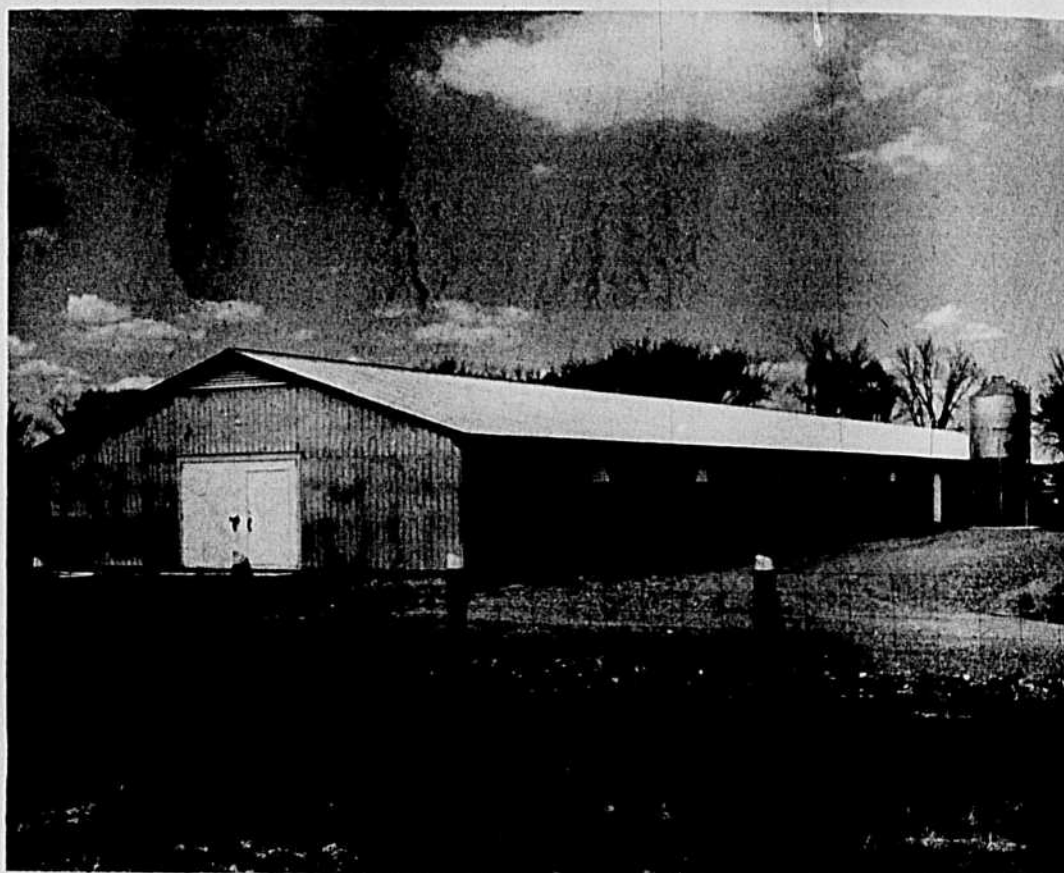
Un poulailler de 192 pieds de longueur et 36 pieds de largeur, caractérisé par l'absence de fenêtres.
