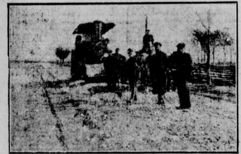
COMMENT ON CONSTRUIT UNE BONNE ROUTE
