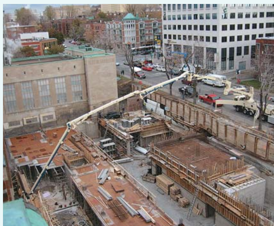
Durant les travaux d'expansion de la Division de radio-oncologie, une pompe spéciale versait du béton liquide à l'endroit approprié.
