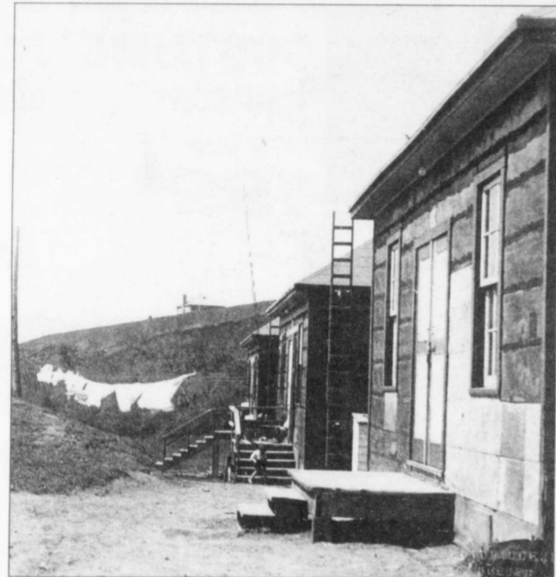
Pour contrer une crise de logement à la fin de la Seconde Guerre mondiale, on avait parqué des dizaines de familles démunies dans des huttes militaires installées dans ce qu'on appelait les « Cove Fields », au beau milieu des plaines d'Abraham. — PHOTOTHÈQUE LE SOLEIL
