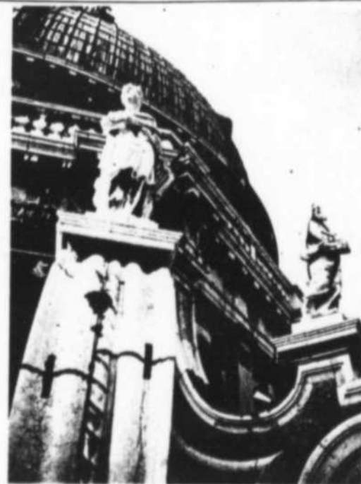
Venise est bien plus belle d'être à demi déchuë — André Suarès Après des siècles de détérioration, ces statues doivent être maintenues par des crampons.
