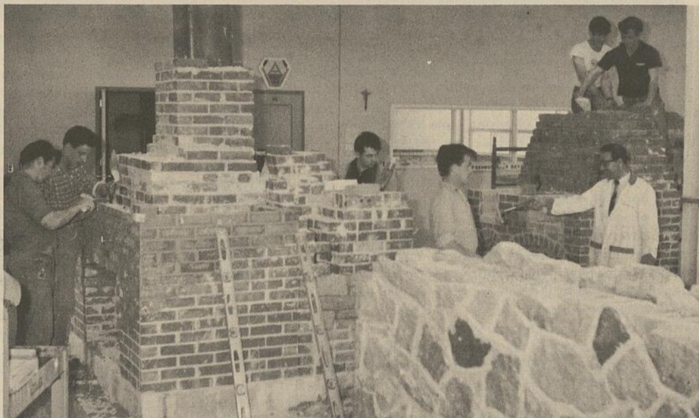
L'ATELIER DE MACONNERIE DE BRIQUE du Centre d'apprentissage des métiers de la construction de Granby offre aux jeunes toutes les facilités d'apprendre à la perfection un métier de plus en plus recherché au moment où le Québec connaît un essor extraordinaire dans la construction commerciale et résidentielle. Dans cet atelier, les étudiants se livrent à la pratique de tous les travaux requis du briqueteur.
