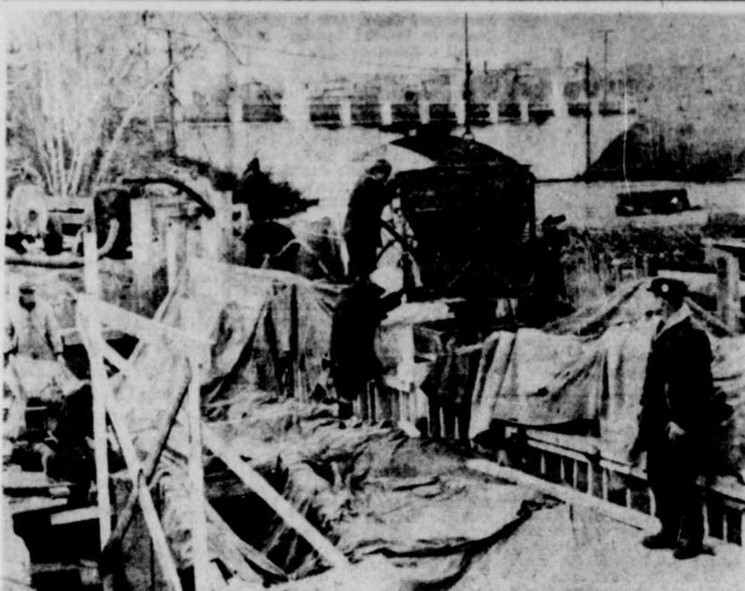
LES PREMIERES verges cubes de béton ont été coulées sur les chantiers de construction du pont de Shawinigan. Sur cette photo on voit des ouvriers travaillant à la base du premier pilier.
